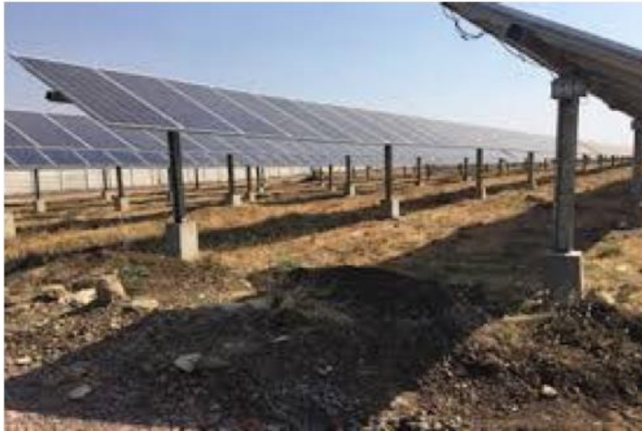
Figura 54. Esempio di impianto fotovoltaico con fondazioni ottenute mediante perforazione del terreno e successiva creazione del palo di fondazione con getto di cemento.
